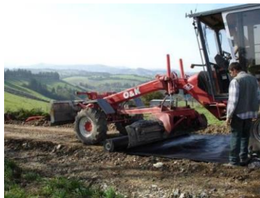
Pose du géotextile
