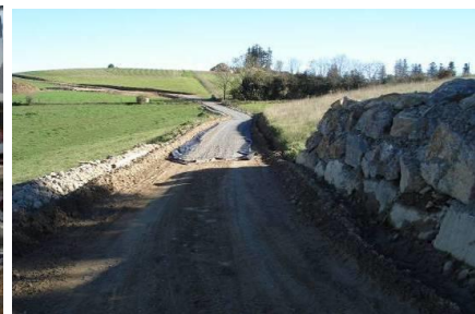
Mise en place du gravier
