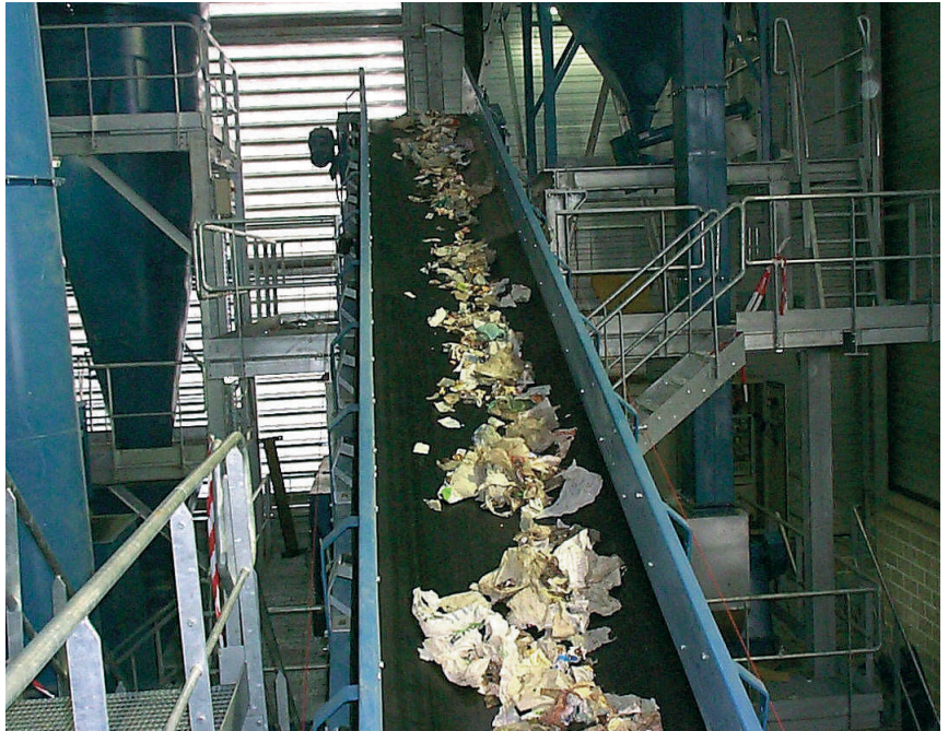
UNITÉ DE TRI DE DÉCHETS MÉNAGERS • SOURCE: ITRADEC
