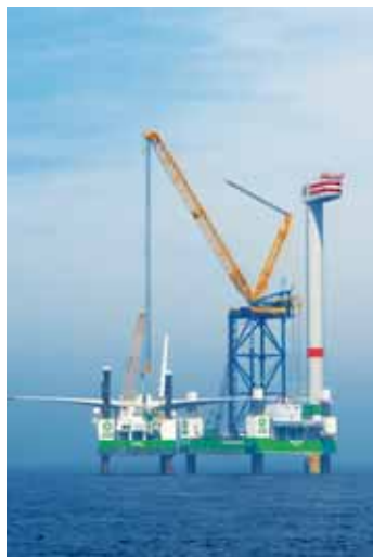
Montage du rotor et des pales de l'éolienne (Source : C-Power)
