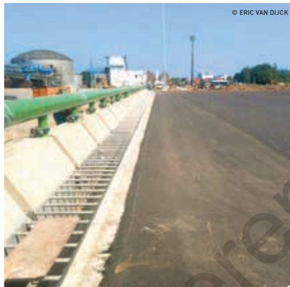
Het nieuwe bietenplein in Tienen, met links het kanaal, waarlangs de bieten door middel van krachtige waterkanonnen de fabriek binnen gestuwd worden.
