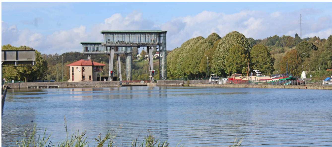
Ecluse 5F (canal Charleroi-Bruxelles) - Balad'eau d'Iltre - @CRSenne
