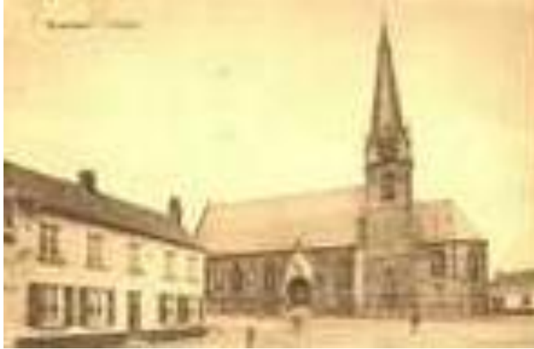
L'église de Baudour
