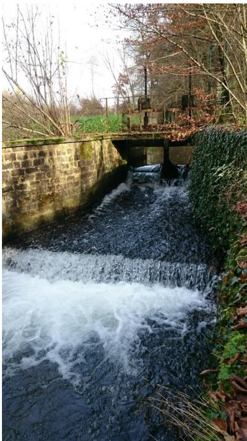
Obstacle infranchissable sur le Ton à La Barrière à Saint-Léger.
