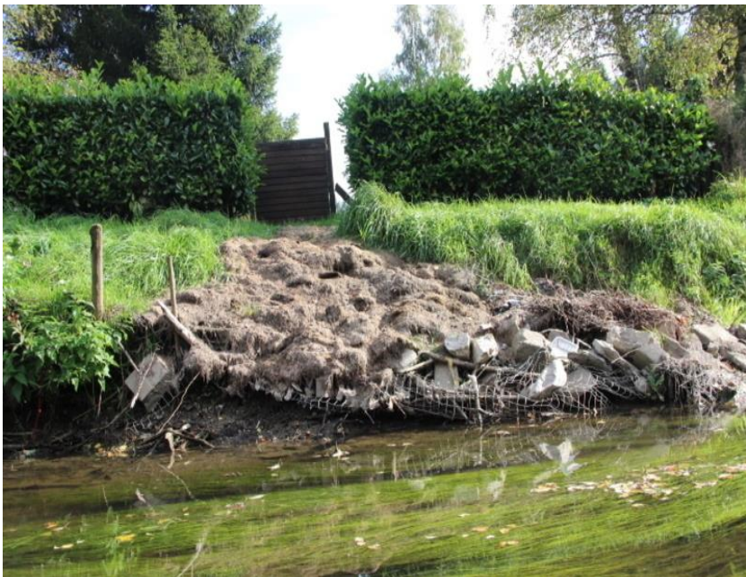
Protection de berge faite en blocs de béton et par-dessus, des tontes de pelouses sur la Semois à Poupehan.
