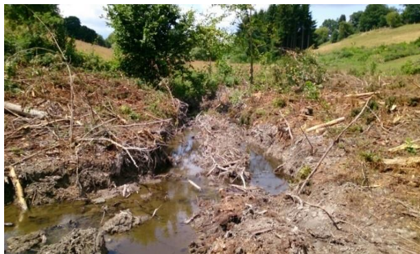
Pas de remise en état du cours d'eau après une mise à blanc (Bouillon).
