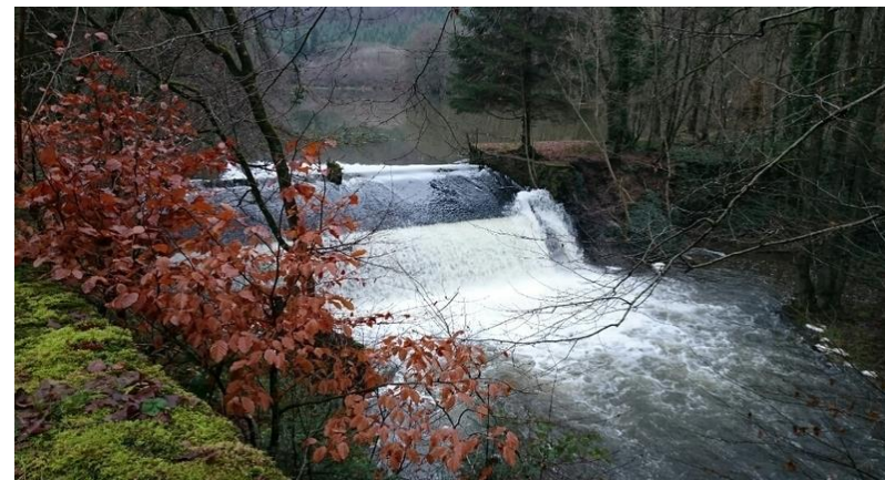
Obstacle infranchissable causé par ancien barrage pour les Forges de Mellier sur la Mellier (Léglise).
