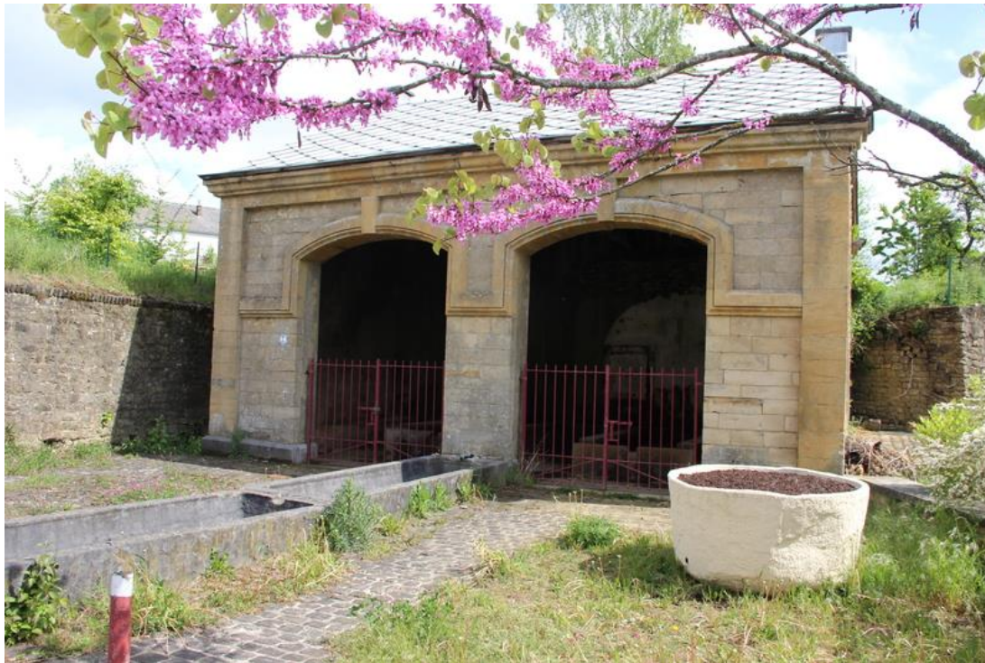
Lavoir de Heinsch à restaurer et valoriser (Arlon).
