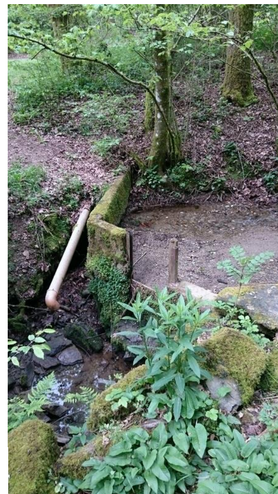
Gros captage pour des étangs sur un cours d'eau non classé en amont de Noirefontaine.
