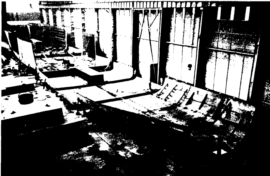
Bouw in fabriekshal en montage op helling
