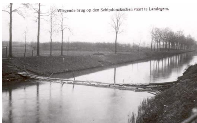
Figuur 28: Geïmproviseerde brug over het Schipdonkkanaal in Landegem, Het Land van Nevele
