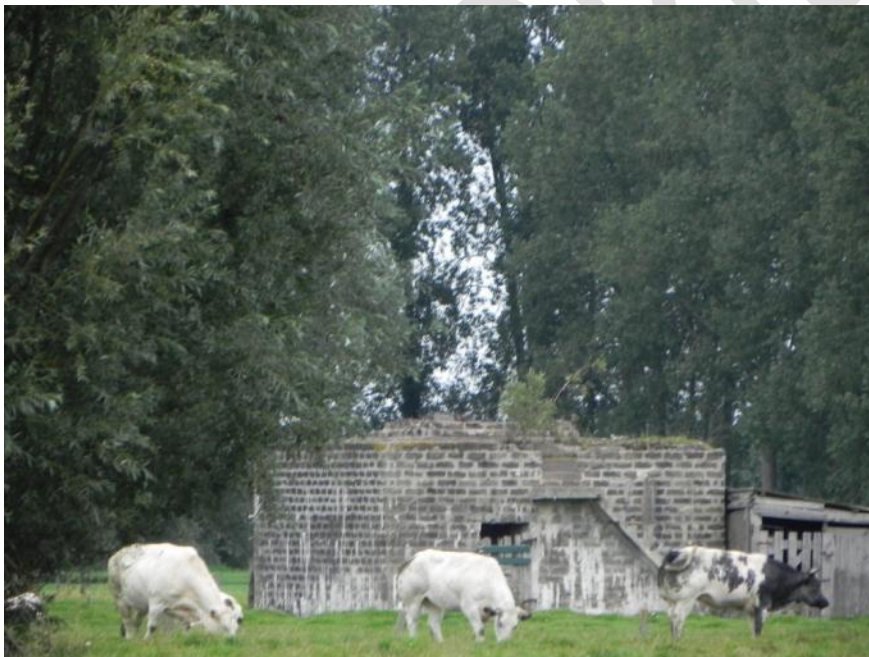
Figuur 13: Observatiebunker in de Moerstraat in Kaprijke, 2011, collectie COMEET
