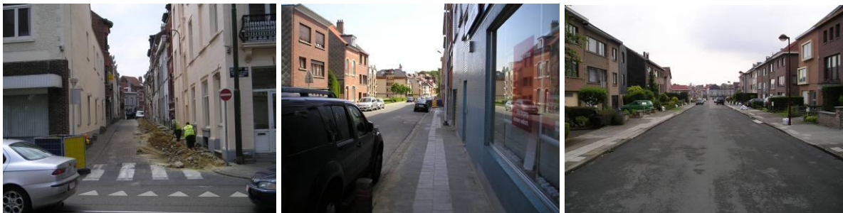
Exemples de tranchées de concessionnaires dont le contrôle de la bonne remise en état doit être intensifié : rue Blauwet, rue des Sept Etoiles, 't Hof te Overbeke (images d'archives).
