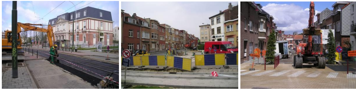
Avenue Goffin, rue de Grand Bigard et rue Van Nieuwenborgh. Exemples d'interventions lourdes passées auxquelles on ne peut que recourir avec parcimonie.
