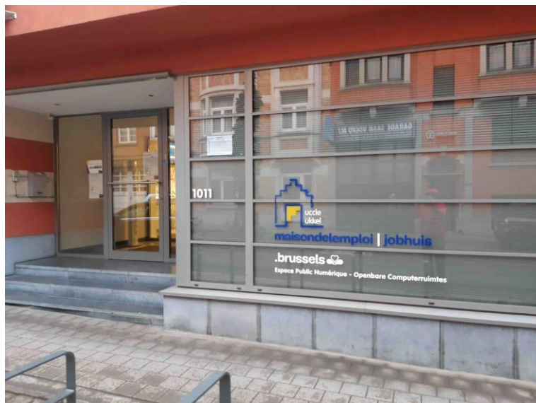
Exemple d'une Maison de l'Emploi en Région Bruxelloise qui intègre un espace numérique public.
