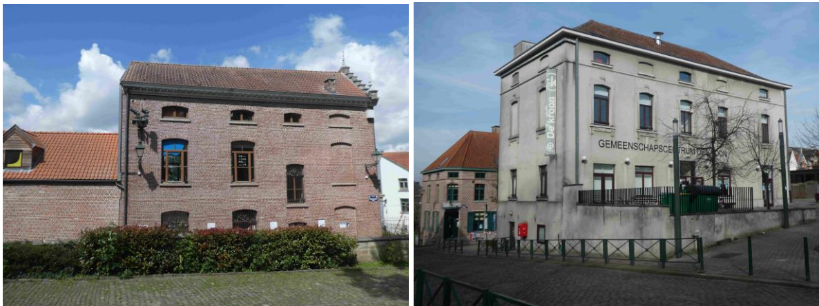
Archipel 19 (à gauche) et De Kroon (à droite) au cœur du noyau villageois original
