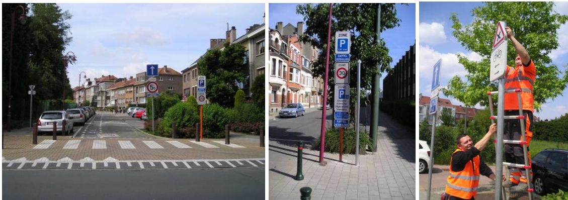
La signalétique verticale a connu un développement exponentiel qui, vu l'évolution des réglementations, n'est plus toujours nécessaire : rue de l'Etoile Polaire, rue Preser (images d'archives). Il faut en poursuivre la rationalisation.
