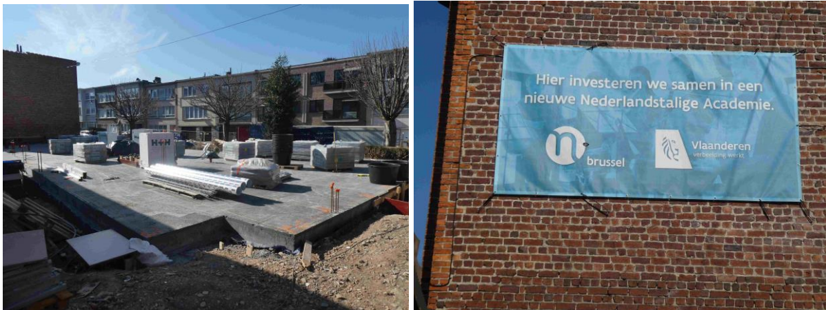
Chantier en cours de l'académie de musique néerlandophone (rue Leemans).
