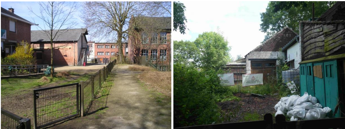
Espace Jeunesse (à gauche, bâtiments sur la gauche), opportunité pour une nouvelle offre sociale ; l'ancienne menuiserie de la rue de l'Allée verte (à droite), site à prendre en considération dans le cadre du master-plan « Allée verte ».
