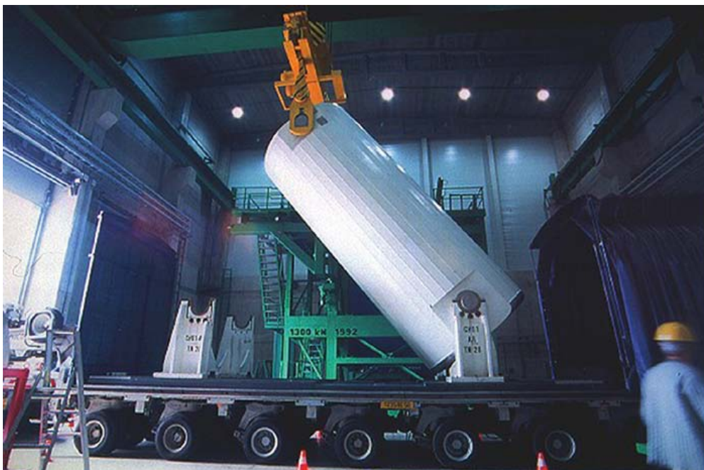
Opslaggebouw voor verglaasd afval
