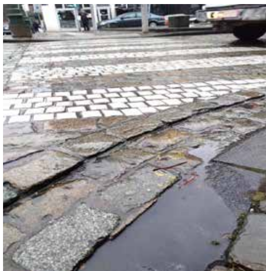
Figure 7-13. Combinaisons de revêtements irréguliers, glissants et dégradés inconfortables et dangereux pour les cyclistes
