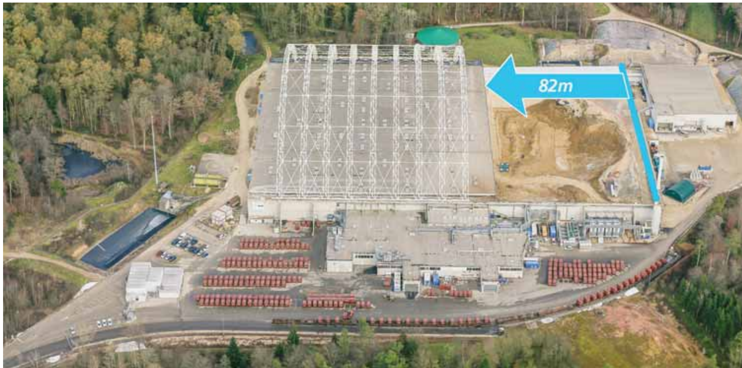
Sur cette vue aérienne du site, on voit bien, à droite, la partie sud de la décharge excavée, et la halle qui a été déplacée du côté nord. BIST-ROGER MEIER
