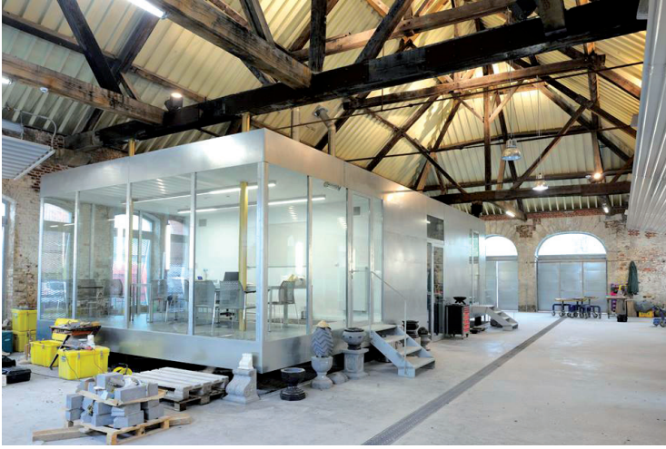
Installation du Pôle de la Pierre. Cliché Pôle de la Pierre, 2016.
