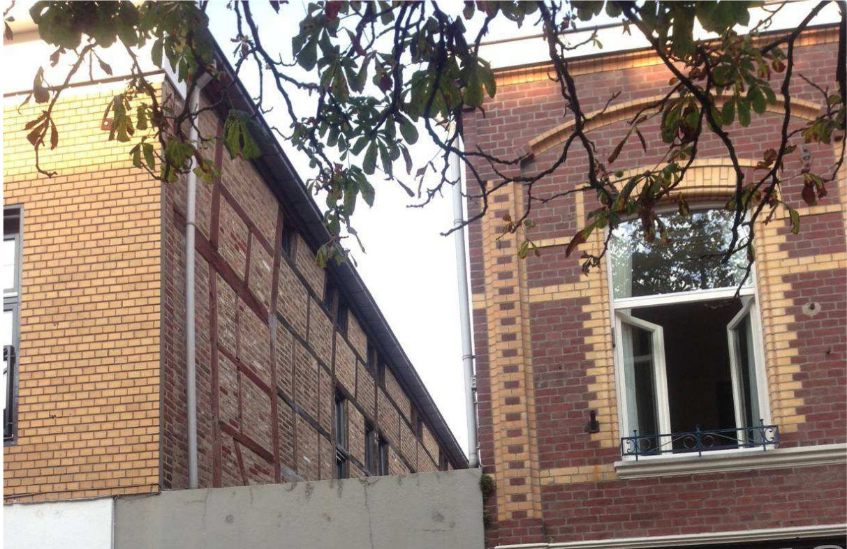
Zijgevel rijksbeschermd monument Langstraat 6
