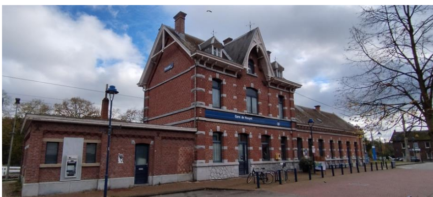
La gare de Houyet avant travaux de rénovation (11/2023)
