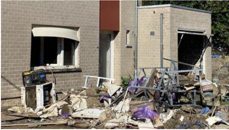
Trois mois après les inondations, certains riverains poursuivent les opérations de nettoyage © Laurent Henrard - RTBF
