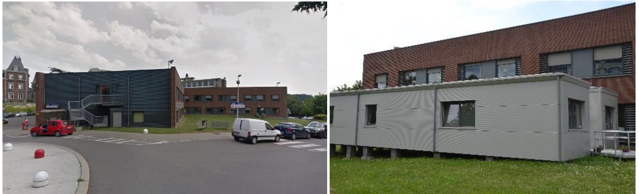
Figure 23 Aile E, vue depuis la route d'accès aux urgences (gauche) et les blocs C7/C8 (droite) (source : CSD, juill. 2023)
