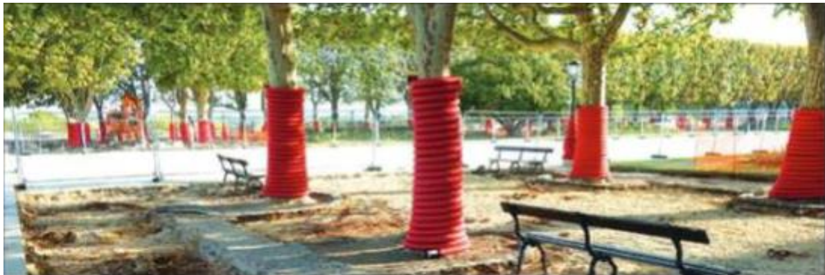
Figure 106 Exemple de protection individuelle d'arbres en phase de chantier.
