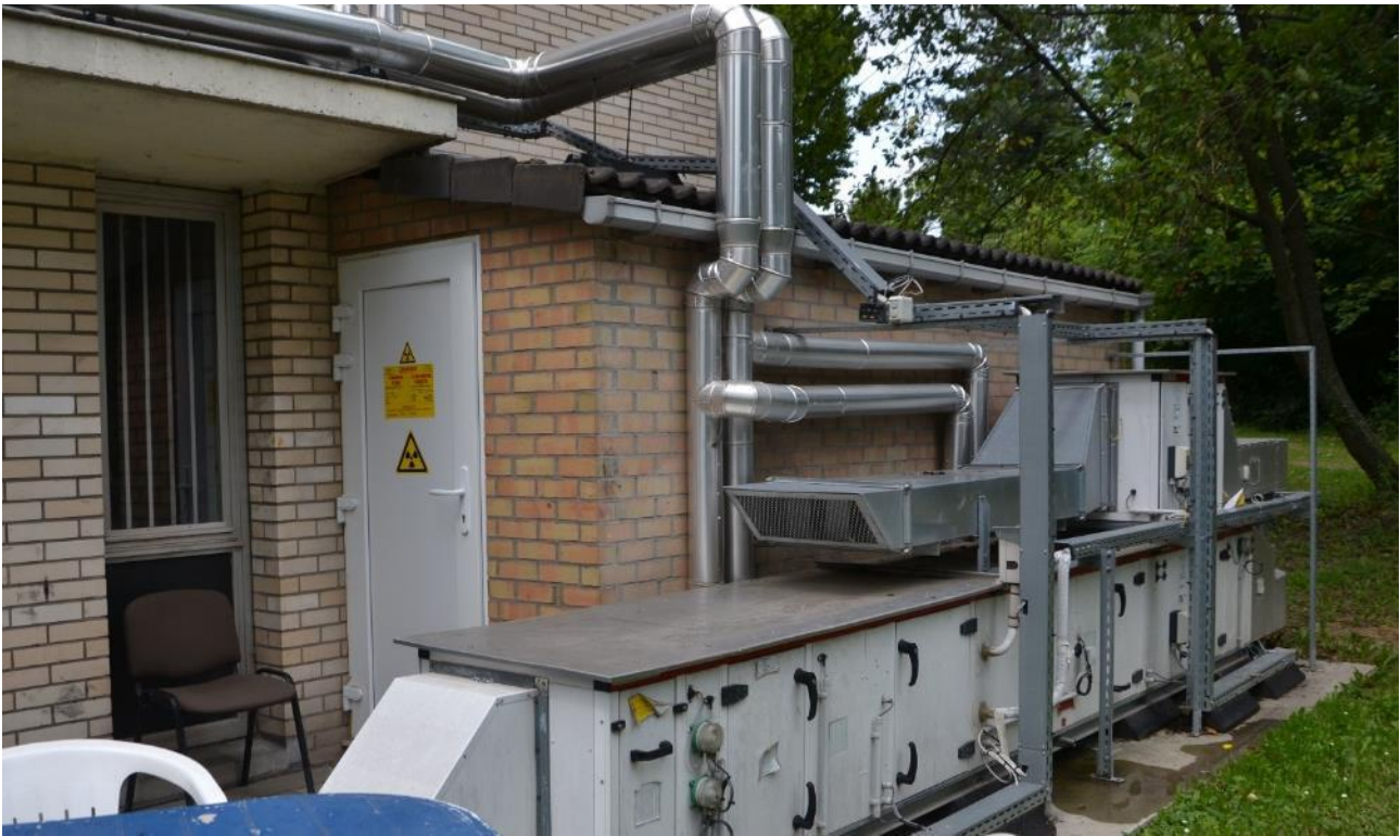
Figure 251 Local de stockage des déchets radioactifs (source : CSD, juill. 2023)
