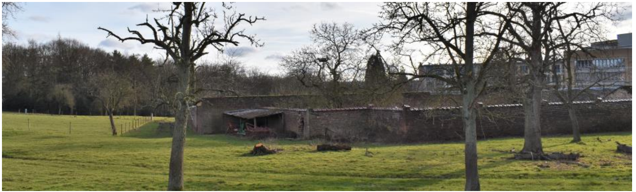
Figure 164 Mur d'enceinte observé depuis le jardin d'un riverain (source : CSD, Mars 2020)
