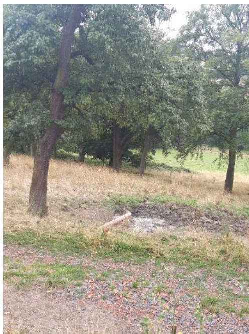
Figure 86 Rejet d'eaux pluviales dans la prairie au sud du bâtiment G (source : CSD, Juill. 2023)
