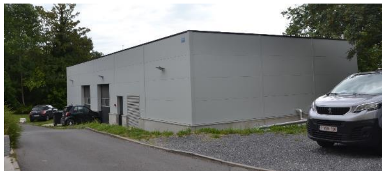
Figure 26 Aile G (chaufferie) (source : CSD, juill. 2023)
