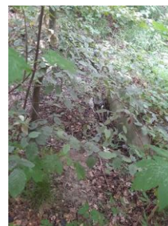
Figure 73 Réseau d'évacuation bouché dans la zone boisée (source : CSD, Juil 2023)
