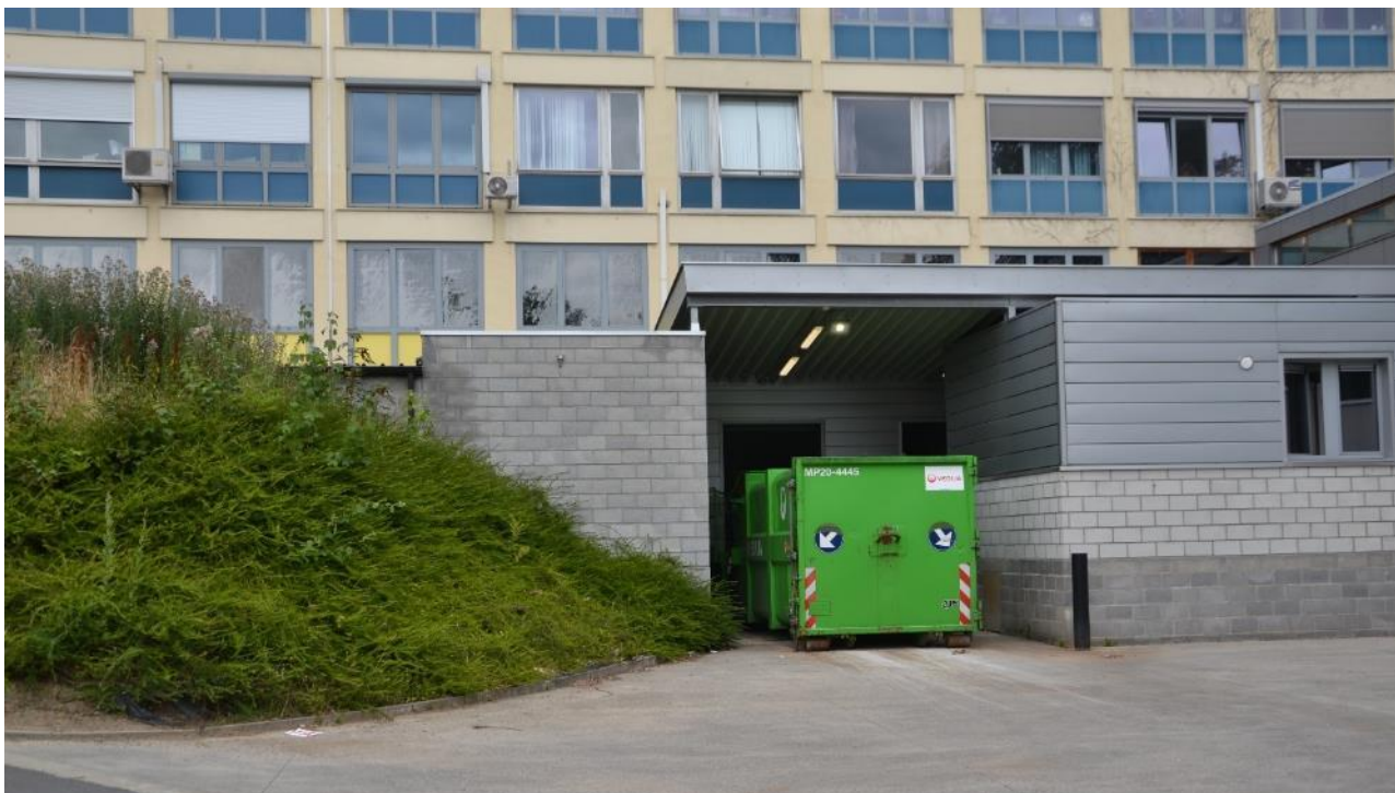
Figure 250 Localisation du compacteur de déchets de classe A/B1 au niveau -2 de l'aile A (source : CSD, juill. 2023)
