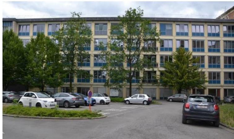
Figure 20 Aile B, vue depuis le parking P7 (source : CSD, juill. 2023)
