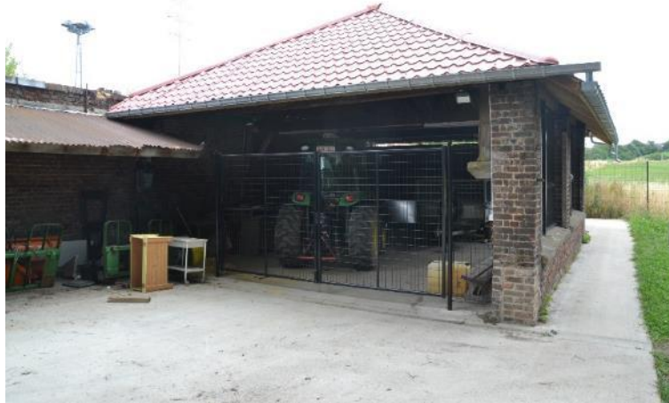
Figure 27 Espace grillagé et fermé du Hangar (source : CSD, juill. 2023)
