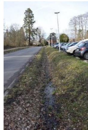
Figure 71 Illustration des fossés destinés au drainage en bordure du parking P1 en situation existante (source : CSD, 2020)
