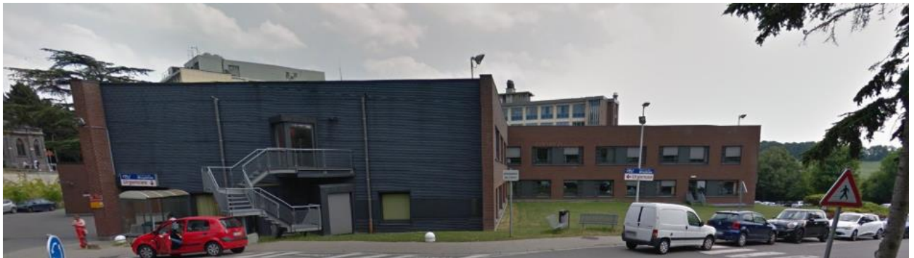
Figure 170 Aile E vue depuis le parking des urgences à l'ouest (source : CSD, Juill. 2023)
