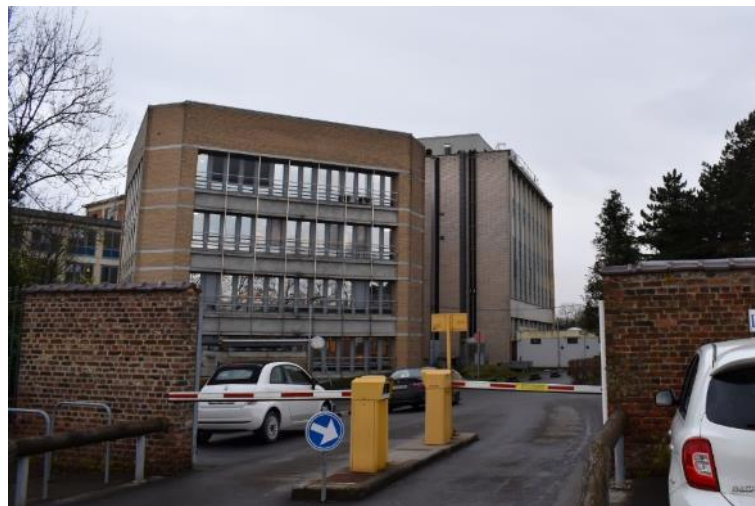
Figure 22 Aile D, vue depuis le parking P5 (source : CSD, juill. 2023)
