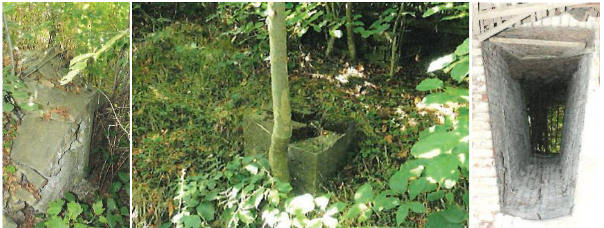
Figure 158 Illustrations des aérations latérales de la fruitière (source : Rapport EXPCO, aout 2019)
