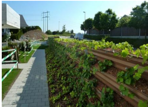
Figure 237 Mur antibruit végétalisé (Source : Naturawall, 2020)
