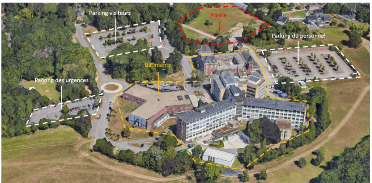
Figure 6 Illustration de la situation de fait au droit du périmètre du projet (source : SPW, 2019)
