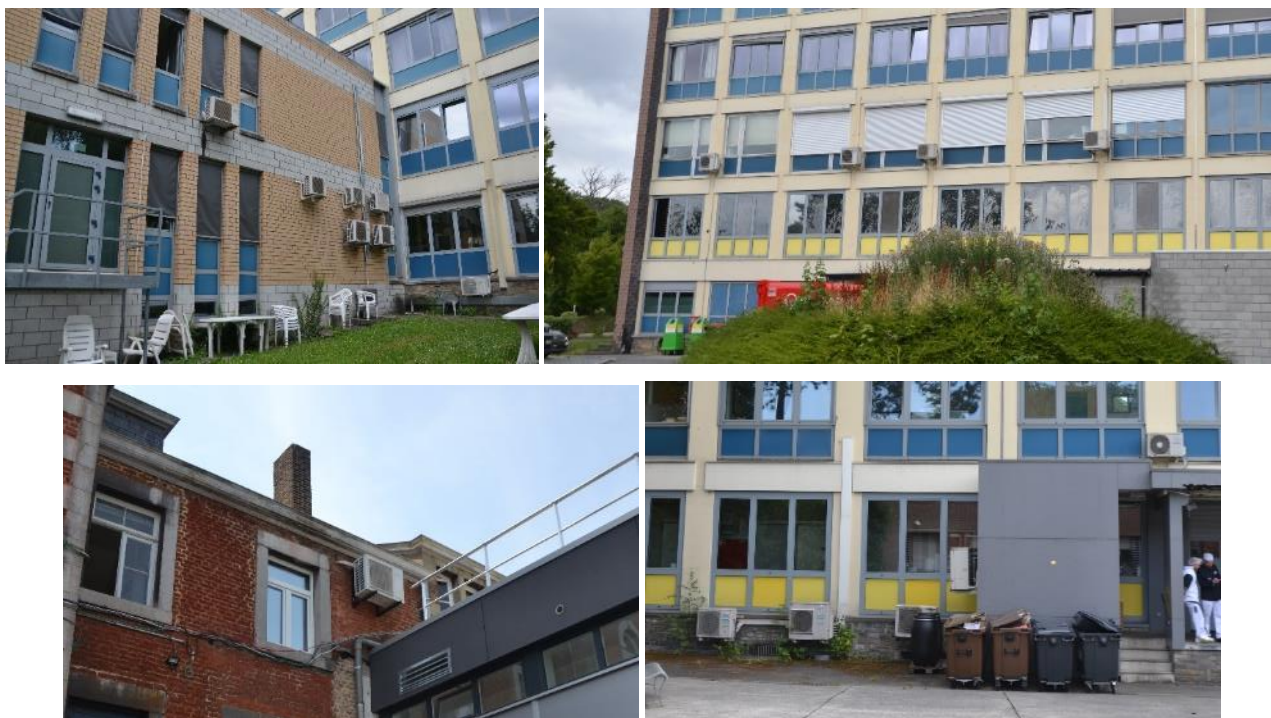
Figure 31 Illustration de la localisation des unités autonomes (source : CSD, juill. 2023)
