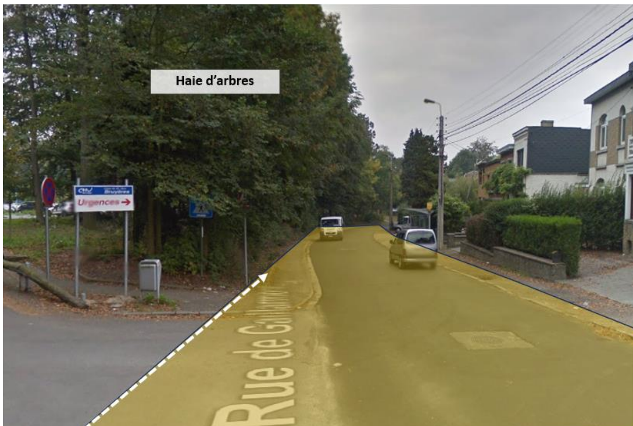
Figure 215 Visibilité en sortie de site à assurer sur l'accès principal existant (source : Street View, oct. 2013 ; CSD, 2023)
