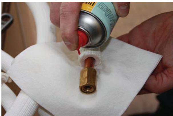
13. Aansluitkoppeling schoonmaken van vet en vuil. (hermetische afsluiting)
