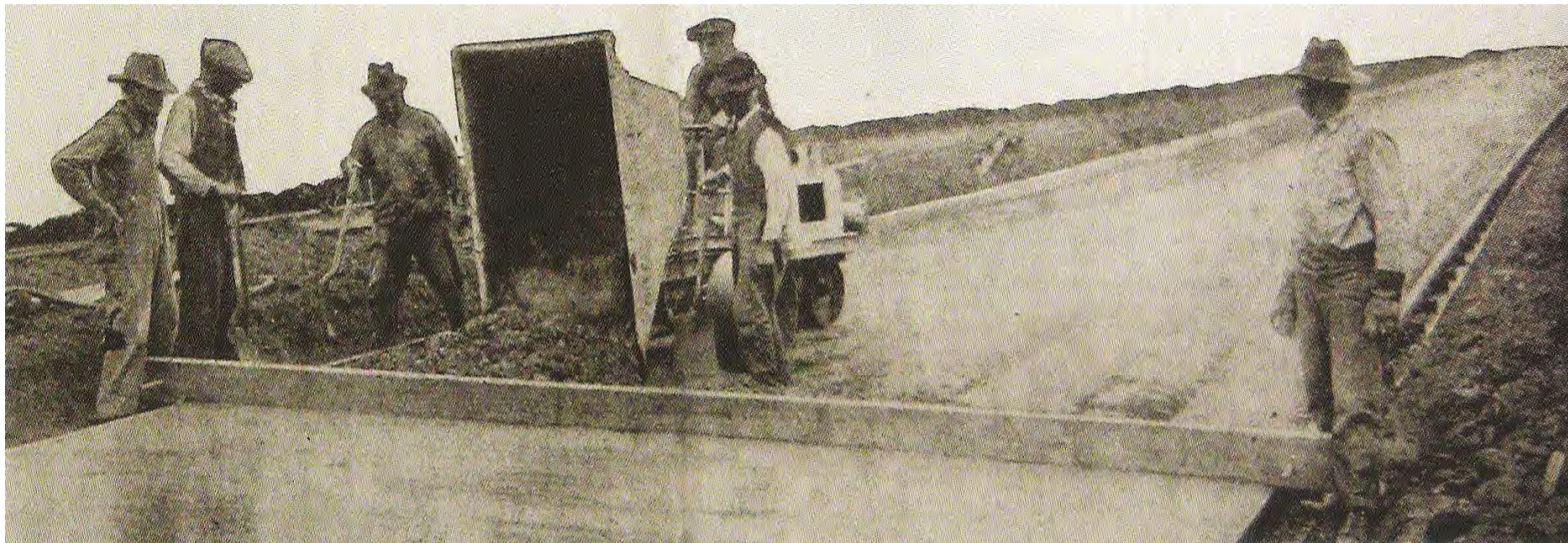
Figuur 26: Aanleg van een betonweg in 1930. (Bron: WEBER D., De blijde intrede van de automobiel in België, 1895-1940 , Academia Press i.s.m. Amsab-ISG, Gent, 2010, p. 231.)
