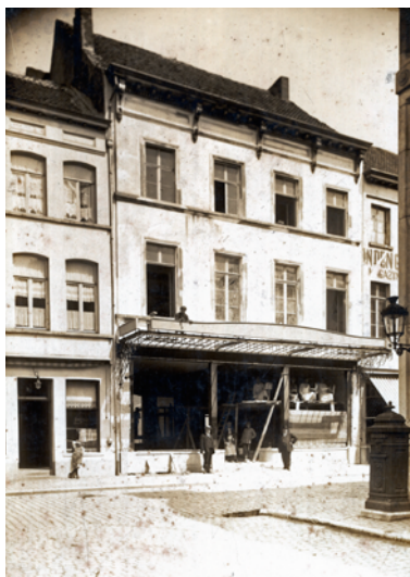
Muntstraat 5, tijdens verbouwing, 1924 (SME001002915)
