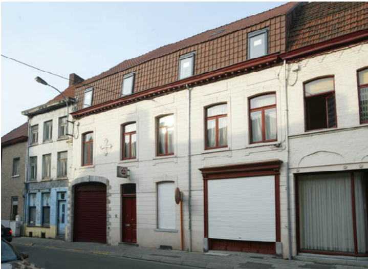
Recent uitzicht van het gebouw, 2003 (VANDEVORST, Koningsstraat 4-6 , 2003, ©Vlaamse Gemeenschap, in: IOE55865)
