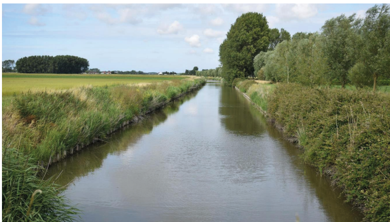
Figure 2 - Le Canal des Chats (Uxem, France), fait partie des voies d'eau gérées par l'IIW. [Source : Pruvost, 2020.]
