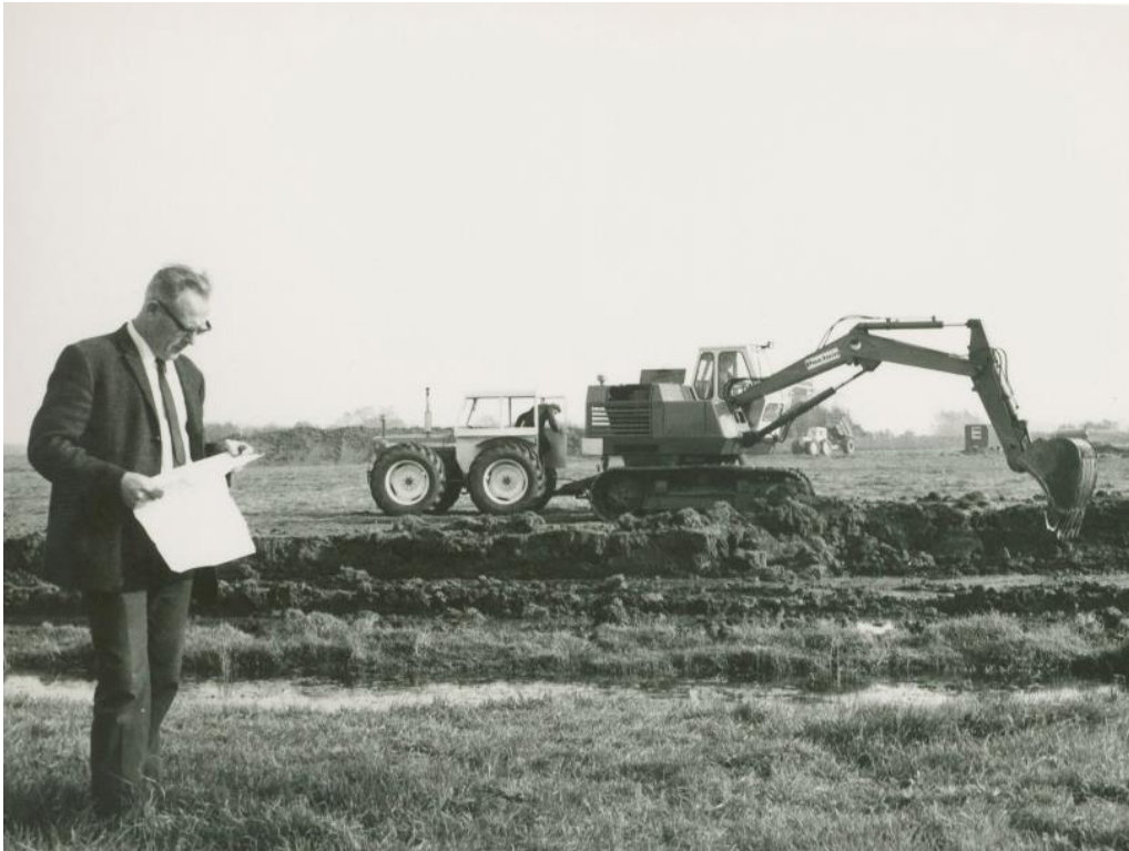
Eerste fase van de zandwinning, 1971. De bovengrond wordt afgegraven en gebruikt voor de nieuwe boezemkade. Er kon niet overal worden gegraven omdat niet alle grond in eigendom van de gemeente was.
