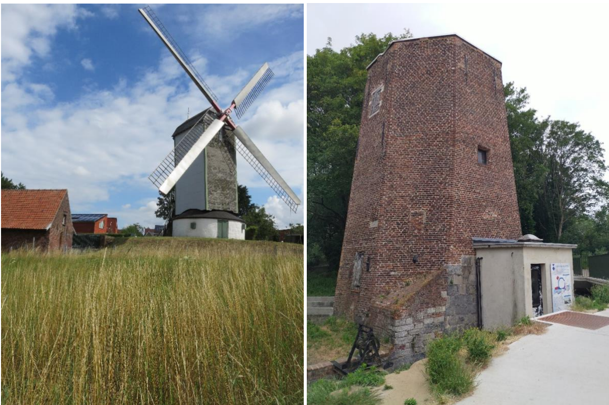
Figuur 4-5 Mortiersmolen in Zwevegem: verdekkerd (foto: Pol Vanneste, 18 augustus 2020) en Hoosmolen in Gent: achtkantig (foto: Hannelore Decoodt, 4 juni 2020).
