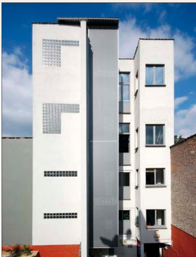
Huis van het Werk De Paraphane, Leopold II-laan, Molenbeek, Doelstelling 2. Architect: Georges Biron.
