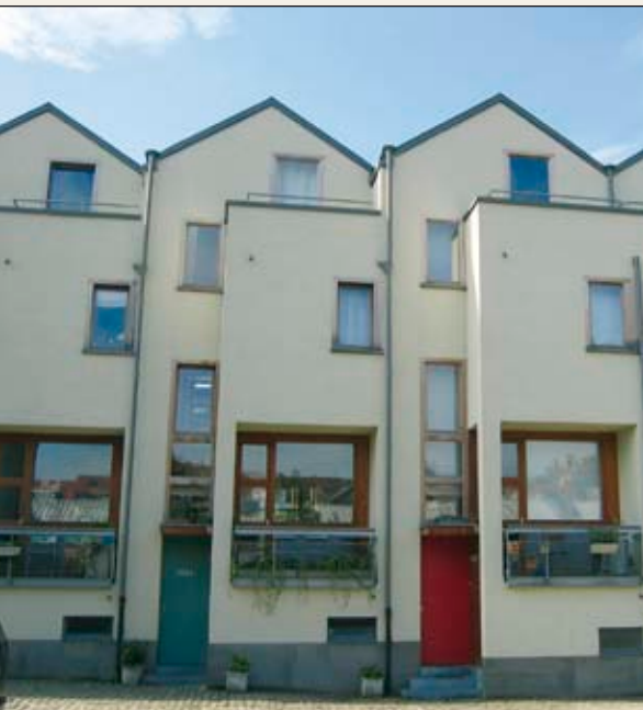
Graystraat, Elsene, Woningfonds. Architect: Serge Devaux.
