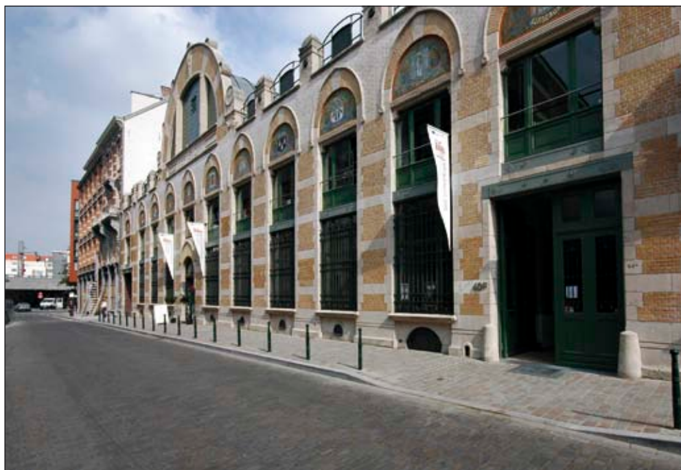
Wijnpalais en Merchie-Pède, Huidevettersstraat en Spiegelstraat, Stad Brussel, Wijkcontract Huidevetters, Doelstelling 2, Monumenten en Landschappen. Architecten: Christophe Gillis, Ozon Architecture.
