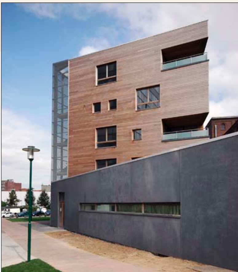
Kinderopvang Elmer West , Fernand Brunfautstraat, Molenbeek, Wijkcontract Bronsfabriek-Pierron en Doelstelling 2, 2007. Architecten: Eric Willemart en Hubert Burtonboy.
