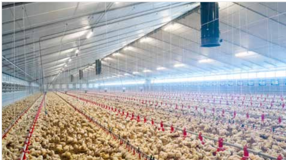
De gladde, met gecoate aluminium cachering voorziene Powerline® isolatieplaten worden in kunststofprofielen bevestigd onder de gordingen en zorgen voor een mooi egaal oppervlak en uitstekende lichtspreading.
