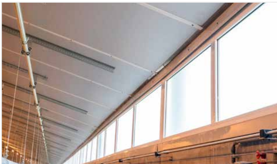
Met deze Powerline® isolatieplaten wordt een mooi, egaal en goed te reinigen plafond bekomen.
