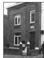
Maison des Sœurs, rue de Genleau
