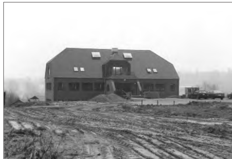
1990, le Centre en travaux.
