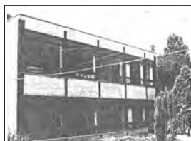
Bâtiment Claire Delépaut.
