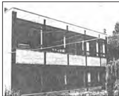
1967, bâtiment Claire Delépat, adossé à la mai- son des Sœurs
