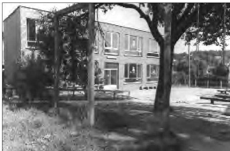
Bâtiment de 4 classes construit grâce à la "Société coopérative pour l'extension de l'Ecole Ste-Lutgarde à Lasne".
