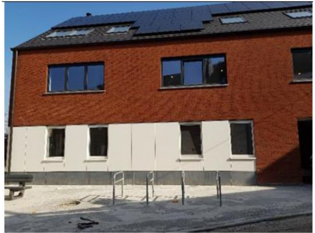
Zicht buitenkant van woning Villa Fura
