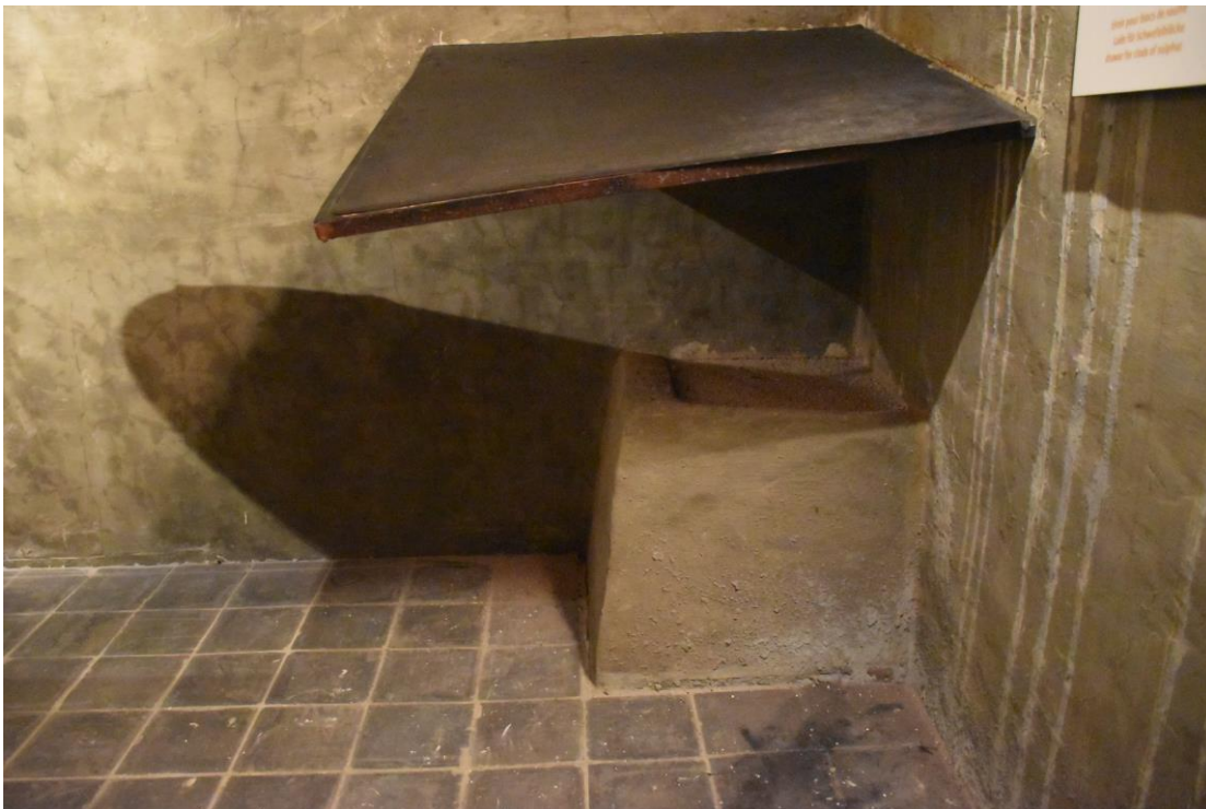
In de 'hellekamer' komt de schouw toe. De ijzeren plaat dient om de damp te verspreiden.
