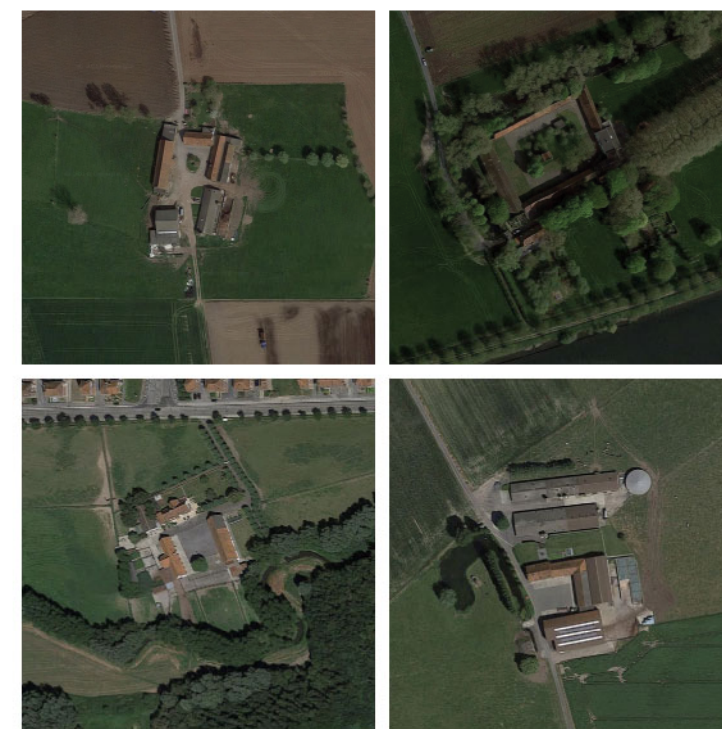
HOEVE MENENSTRAAT, WEVELGEM DE ABIJPOORT (MONUMENT) KLOOSTERSTRAAT, WEVELGEM HOEVE HONDSCHOTENSTRAAT, GULLEGEM HOEVE ZUIDHOEKSTRAAT, MOORSELE
