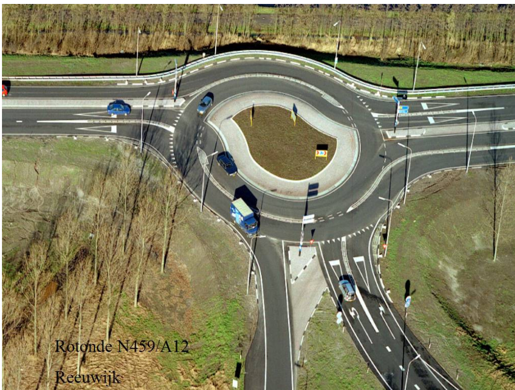
Foto 6: Overrijdbare middengeleiders t.b.v. uitzonderlijk vervoer op turborotonde
