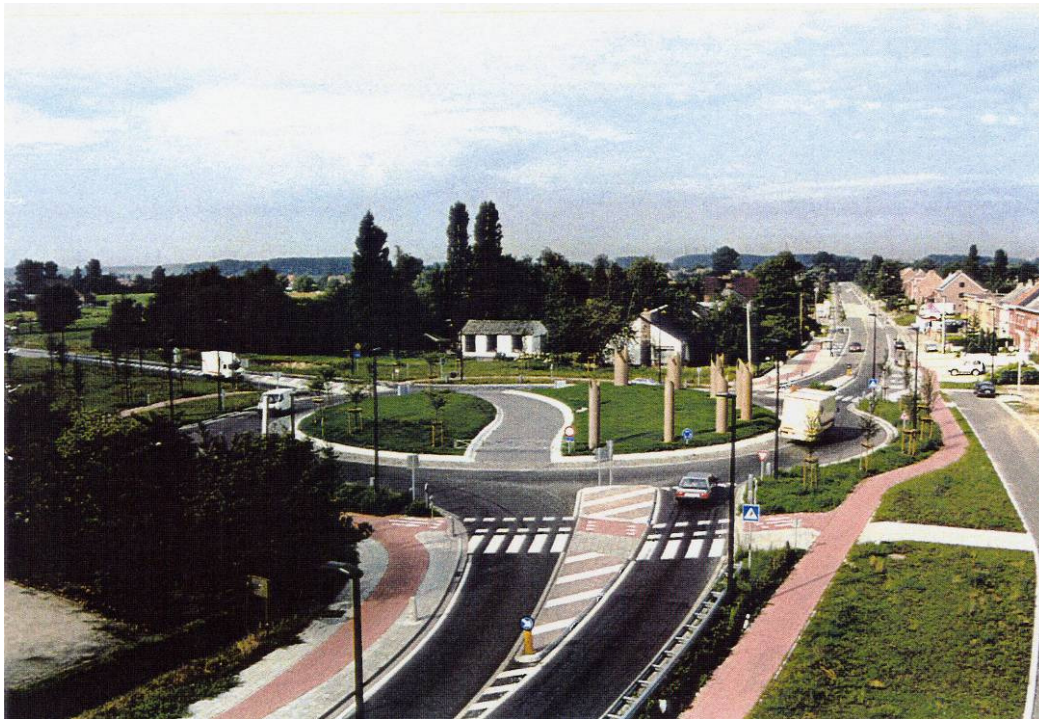
Foto 5: Afsluitbare doorsteek in het middeneiland voor uitzonderlijk vervoer
