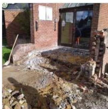
ANDENNE : rue Provost - Maison de quartier « Le Hangar » - Démolition de l'ancienne rampe PMR et construction d'un nouvel accès PMR
