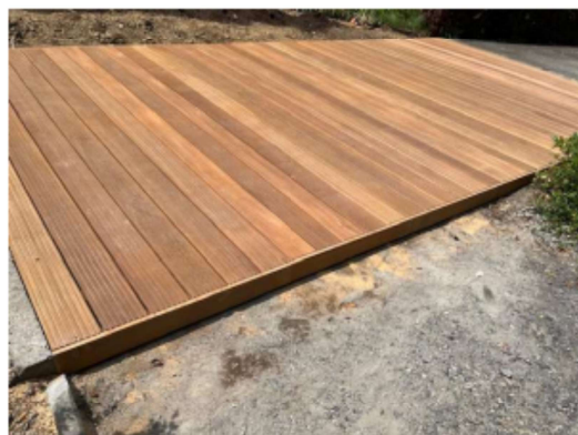
Photo 6 : Réalisation d'une terrasse en bois exotique au Parc Wauters à SEILLES
