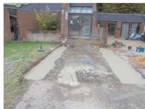
ANDENNE : rue Provost - Maison de quartier « Le Hangar » - Démolition de l'ancienne rampe PMR et construction d'un nouvel accès PMR
