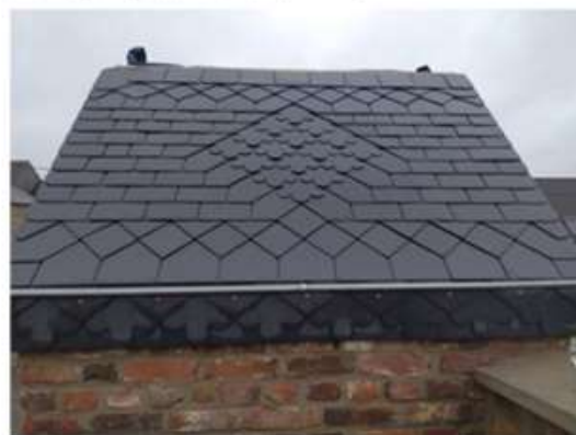
Photo 8 : Fin des travaux de rénovation de la toiture de la chapelle du cimetière de COUTISSE
