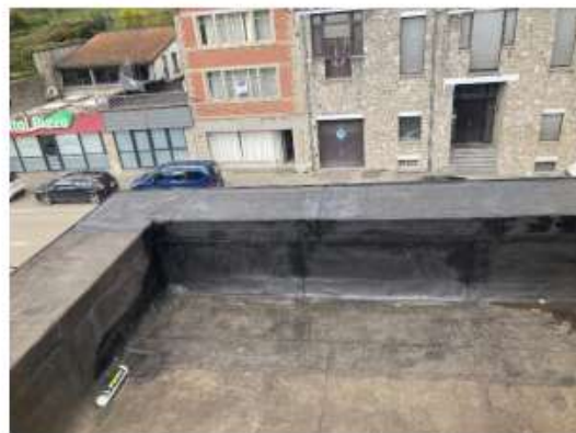
Photo 7 : Remplacement de l'étanchéité de la toiture plate d'un bâtiment communal à NAMECHE
