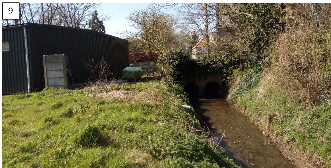
| Waterloop van de hoge landen
