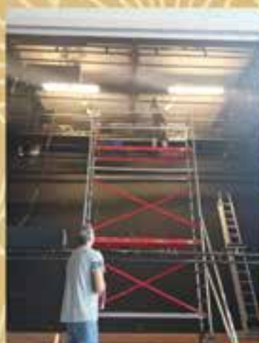
TRAVAUX DE RÉNOVATION DE LA SALLE CULTURELLE
