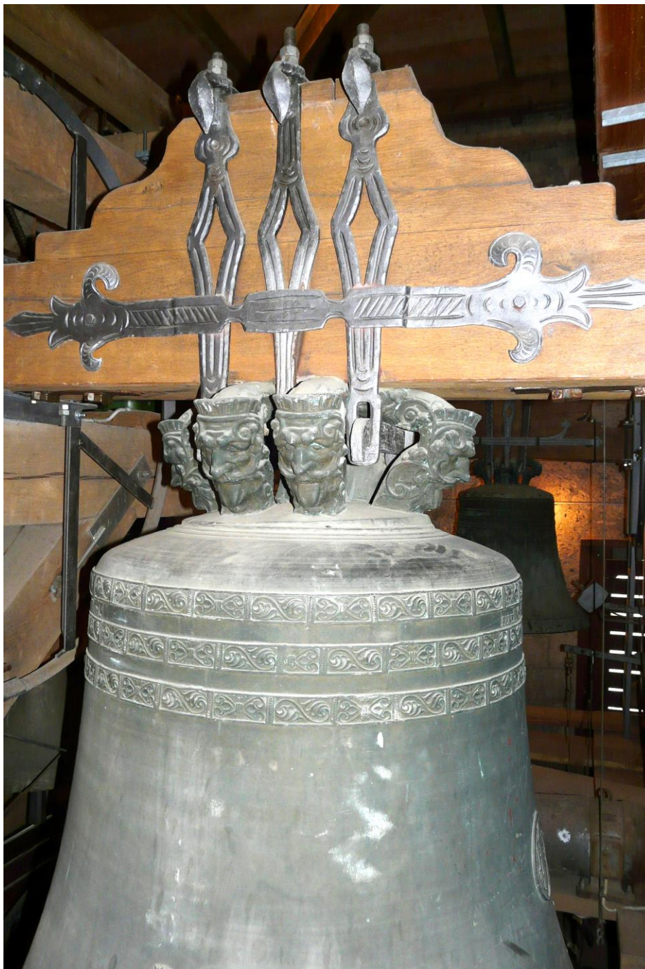
Cerveau, couronne, cornets en « Têtes d'hommes » et brides de suspension du bourdon (4.864 kg) © ACW
