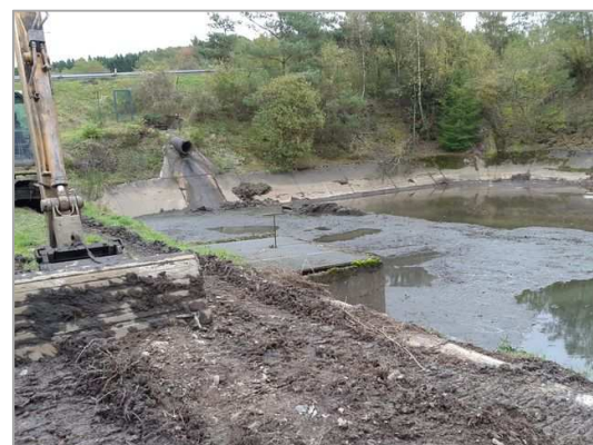
Figure 47: curage du bassin d'orage
