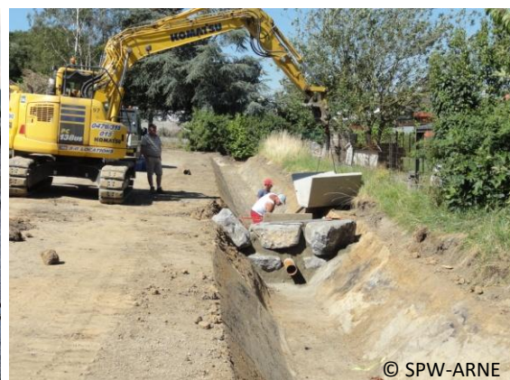
Figure 36 : rénovation d'un fossé
