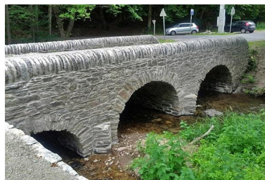
Figure 43: Pont des Gades sur l'Almache à Gembres (Daverdisse)
