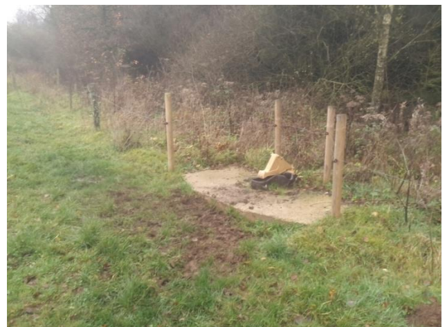
Figure 56 : pose d'une pompe sur le Ruisseau des Raymonds (Bièvre)
