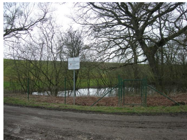
Figure 32 : captage 'Neuve_Fontaine' à Rochefort
