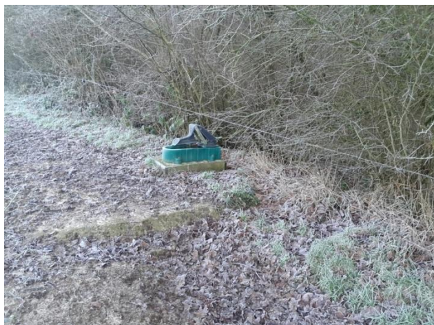
Figure 55 : pose d'une pompe à museau sur la Lesse (Dinant)
