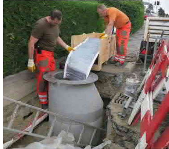
Mise en place de la gaine pour le « chemisage »
