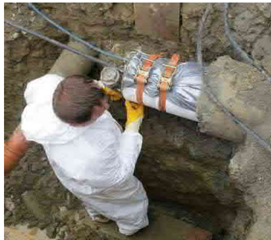
Durcissement de la gaine par polymérisation UV
