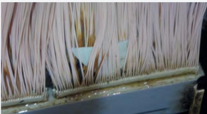
Morceau de revêtement des parois des tanks membranaires se retrouvant dans les membranes
