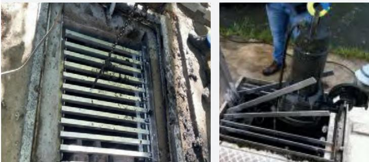
Grilles anti-chute, intégrées au CSC dès la conception d'une nouvelle construction ou rénovation de station de pompage
