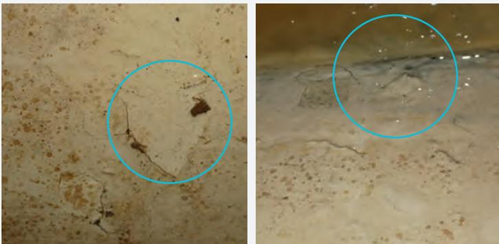
A gauche, fissure, et à droite, boursoufflement au niveau du revêtement
