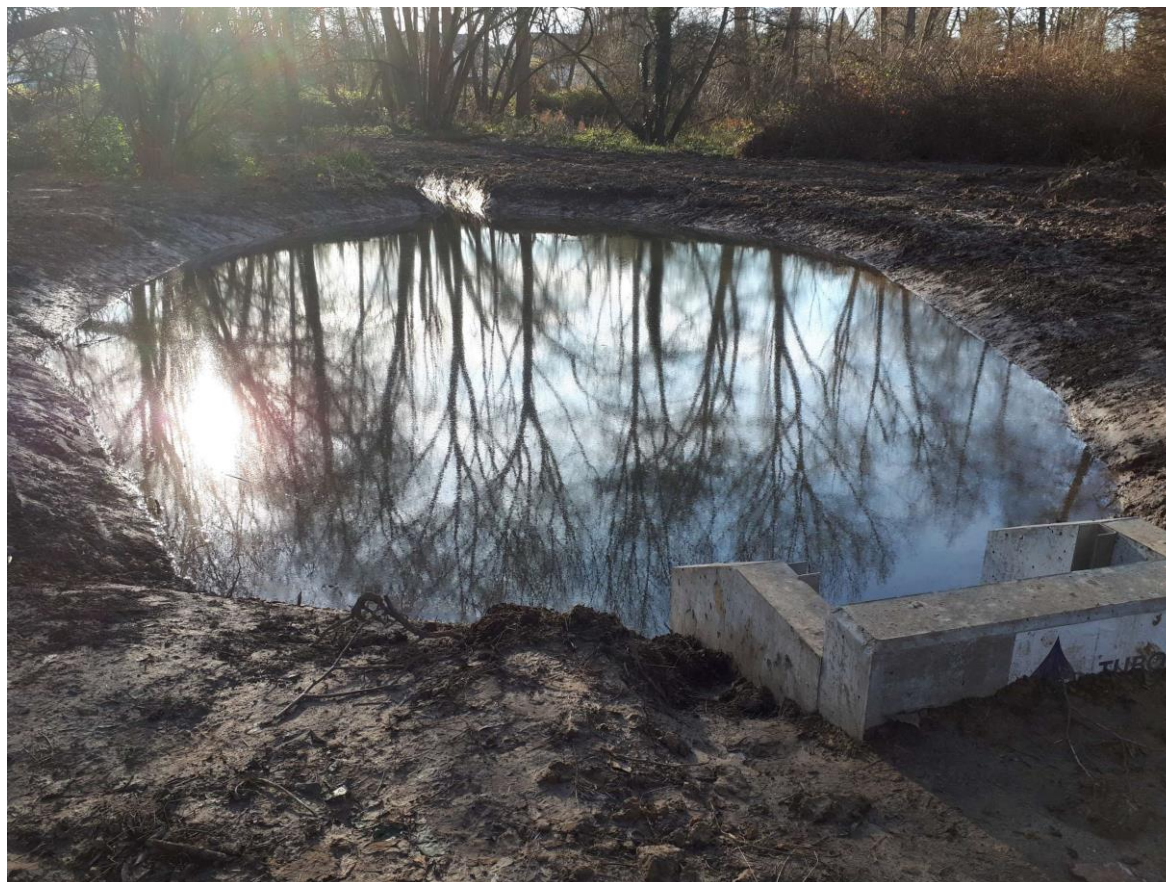
Bron die eerst in moerriool terecht kwam wordt nu afgevoerd naar de Kleine Maalbeek
