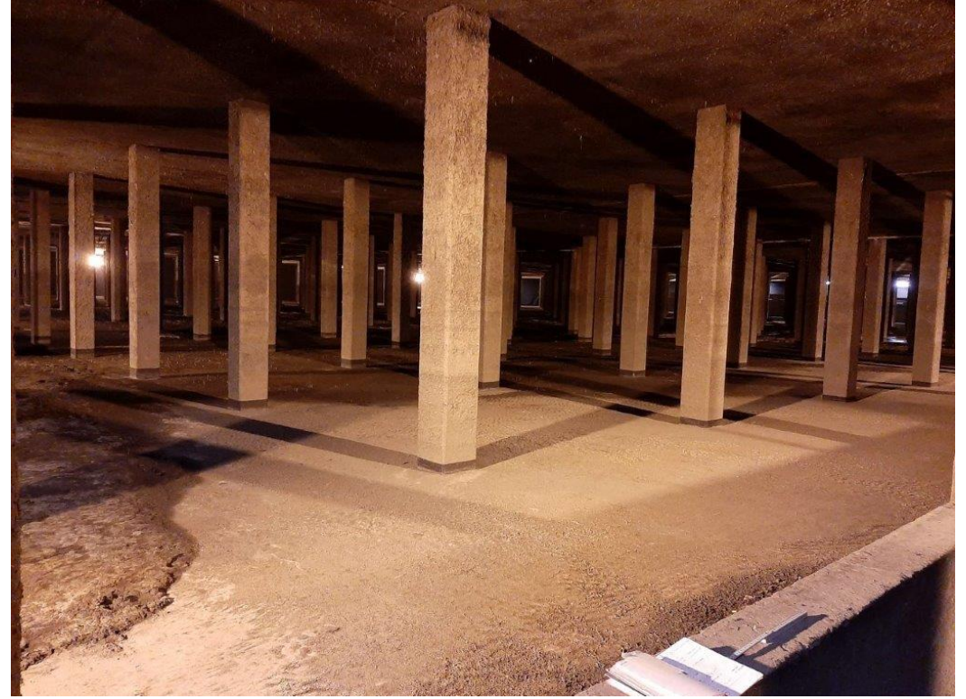
Door menging afvalwater en regenwater in moerriool is momenteel enkel ondergrondse buffering mogelijk (wachtbekken Courdent)
