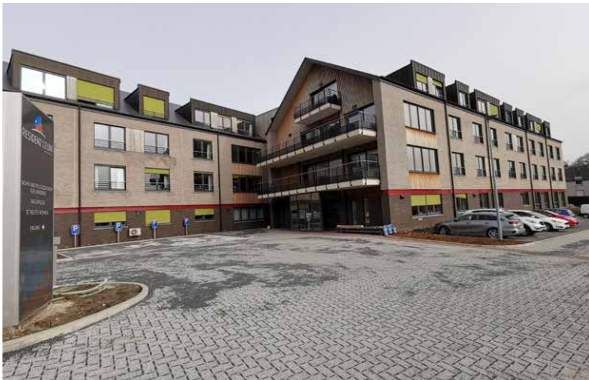
La construction a coûté environ 15 millions d'euros.
