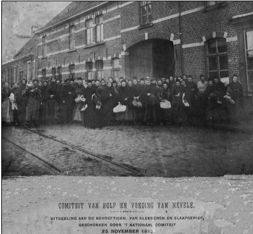
Comiteit van Hulp en Voeding van Nevele in 1915 in de Tielstraat te Nevele (Verzameling Walter De Smet).
