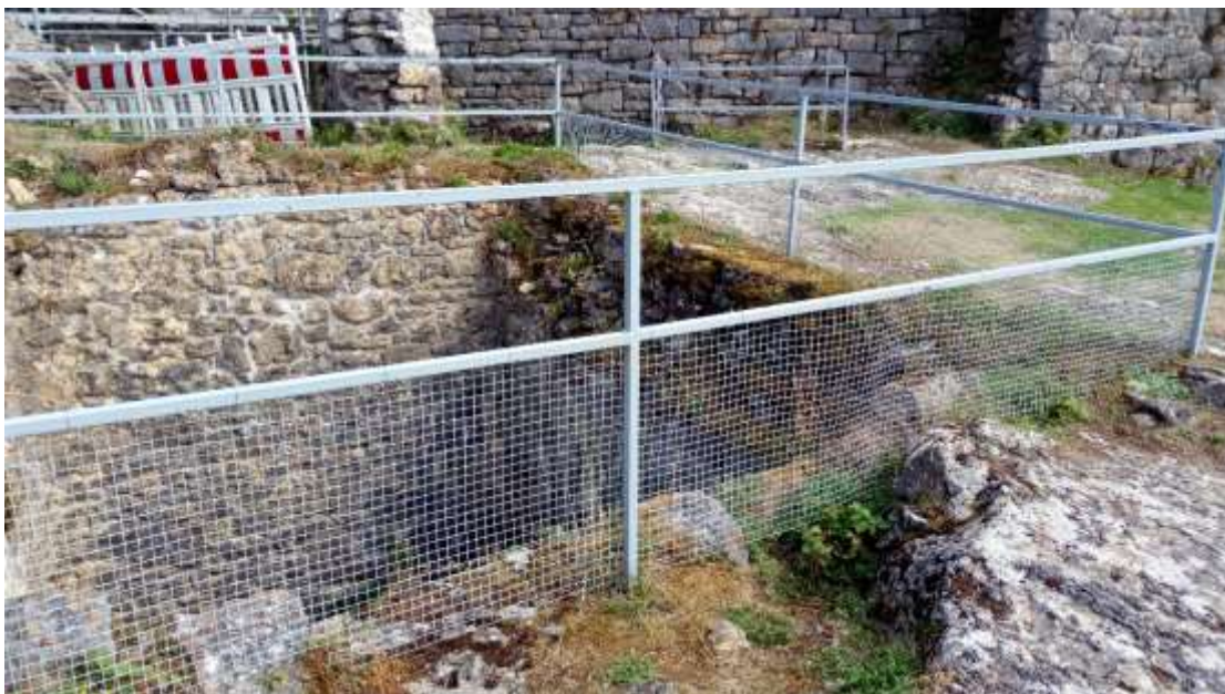
Pose de grillage de protection sur les garde-fous existants.
