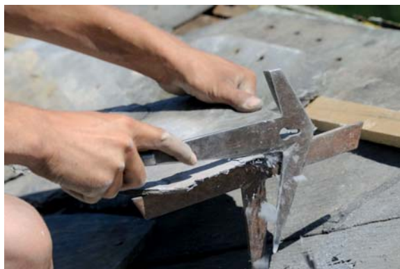
De leisteenpannen: min of meer dikke onderaan gebogen leisteenplaten.
