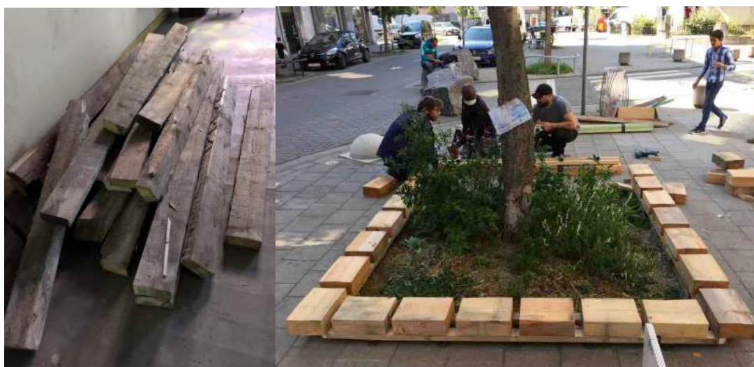
Gites issus d'un chantier de charpente Quartier Heyvaert
