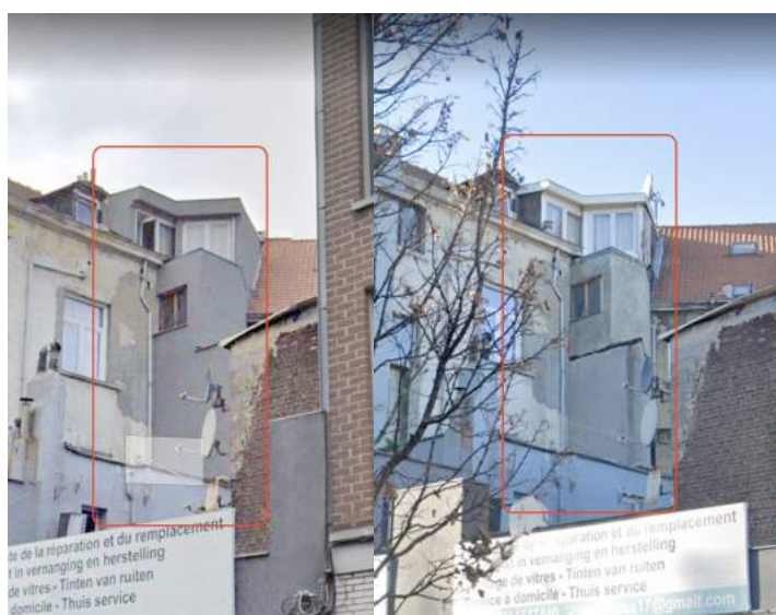
Volumes arrières avant travaux
