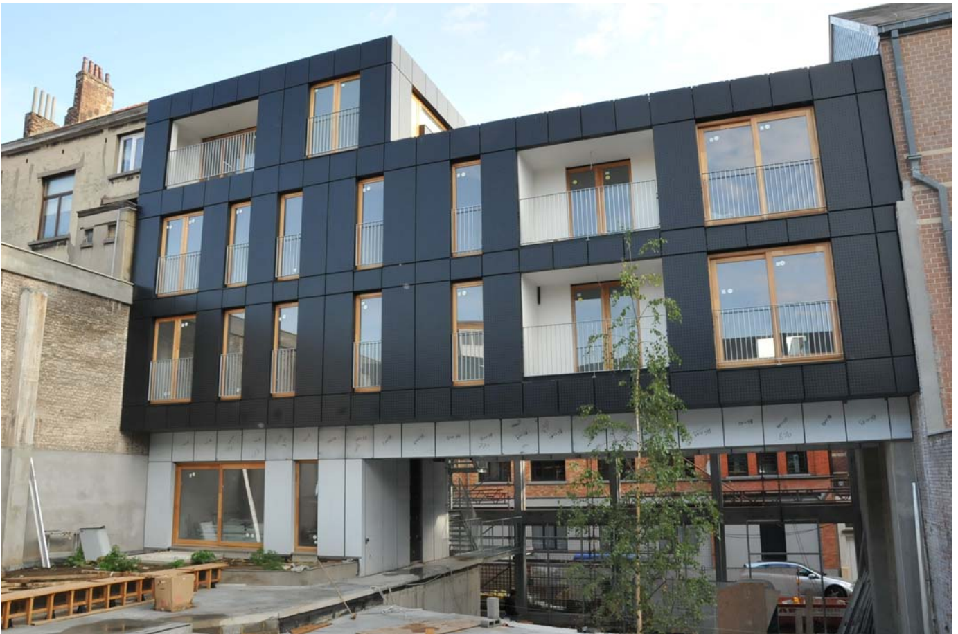
Realisatie gebouw Le Lorrainstraat
