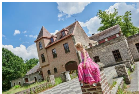
Figuur 32 - Het hoofdgebouw van De Grote Hof in Overpelt
