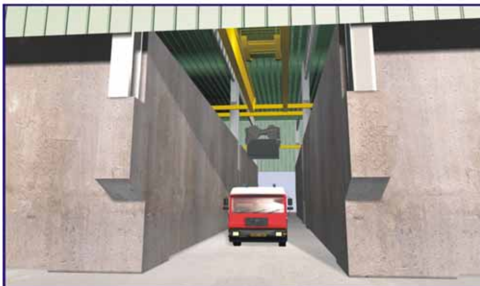
Figuur 39: de aanvoer via een vrachtwagen onder het tijdelijk dak (boven en midden) en de grijper (onder)
