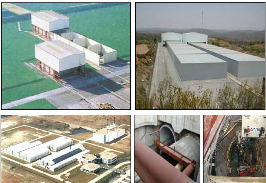
Figuur 13: de berging van: Centre de l'Aube (linksboven, bron: ANDRA), El Cabril (rechtsboven), de tijdelijke opslaggebouwen COVRA (linksonder, bron: COVRA), de tunnel voor de HSL in Antwerpen en de uitgraving (midden) van EURIDICE (rechtsonder, bron: SCK•CEN)
