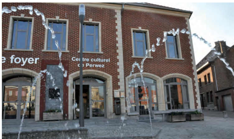
Le Centre culturel de Perwez a entièrement rénové en 2008.
